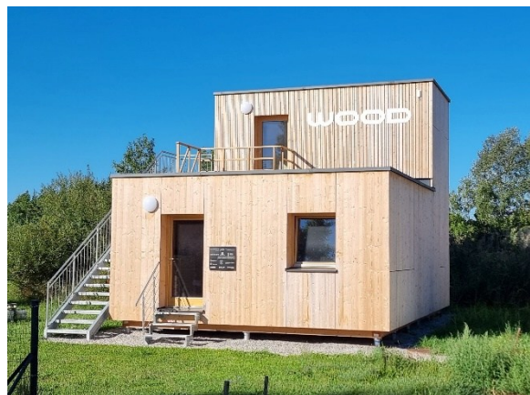
Demonstratorgebäude zur Wiederverwendung von Holzbauerelementen in Tulln (©Foto: Wood K plus)
